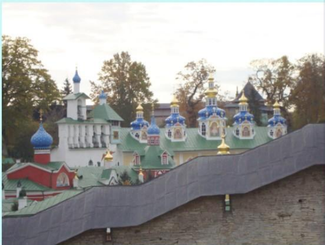
Псковская область г. Псков Свято-Троицкий Псково-Печерский монастырь. Вид со смотровой площадки на монастырь
